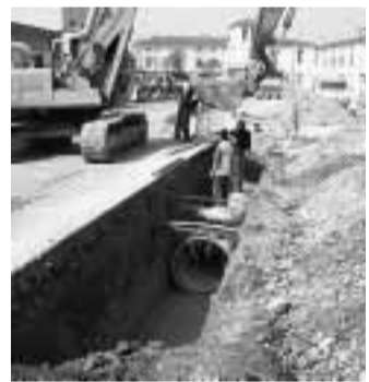
I lavori alle fognature
